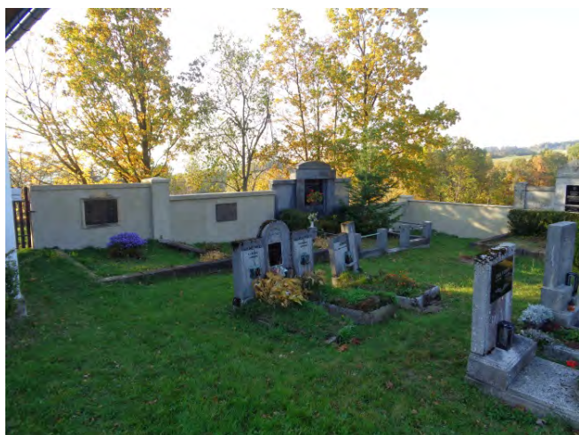
Oprava hřbitovní zdi
