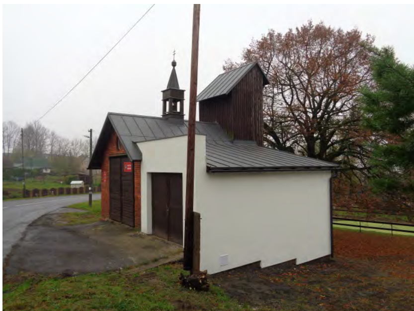
Zateplení a nová omítka na hasičské zbrojnici
